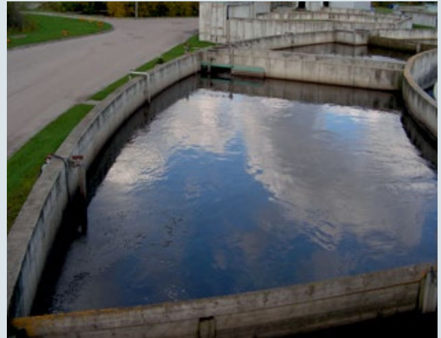
Bild 5. Kommunale Kläranlagen vor und während des Gebrauchs von GREASOLUX: nach dem einige Monate dauerndem Gebrauch wurde die Fettschicht im Belüftungsgefäß völlig entfernt.
