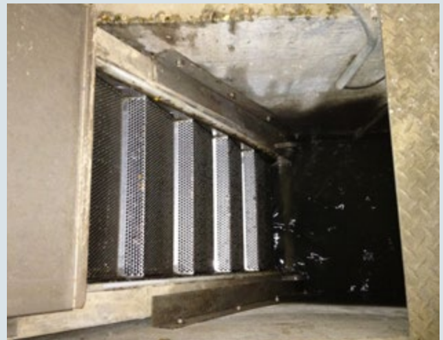
Bild 6. Abwasserpumpstation und Gitter vor und nach dem Gebrauch von GREASOLUX.
